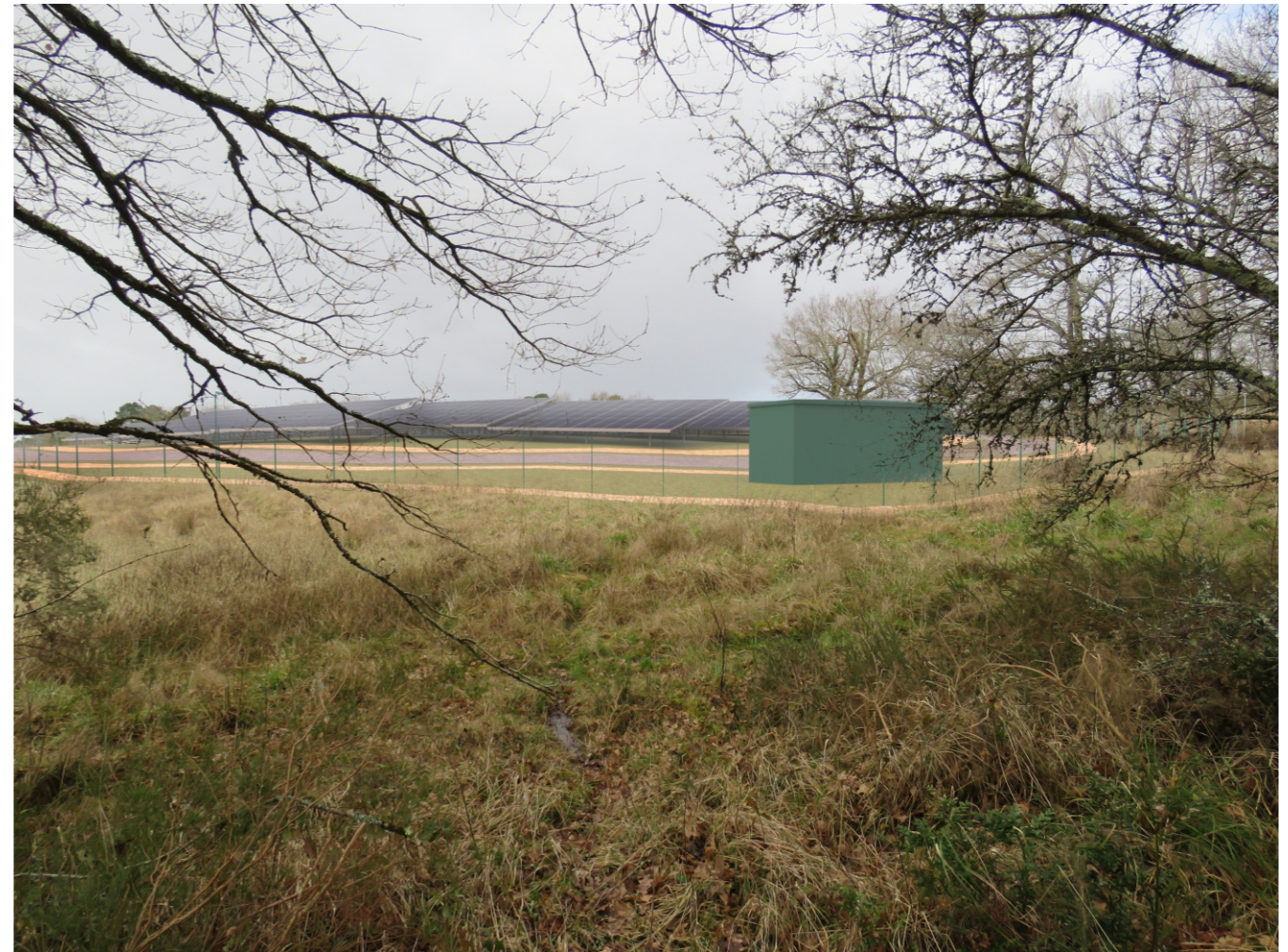
Etat final du site
