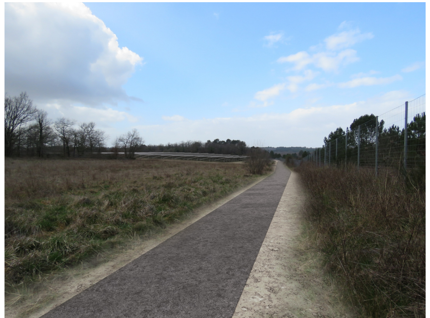
Etat final du site
